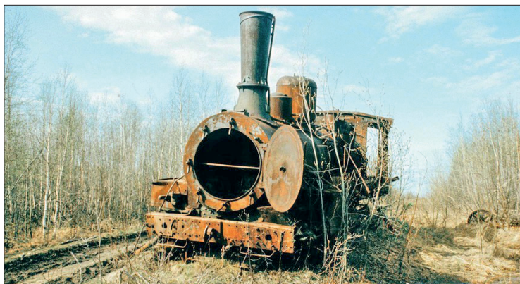
Брошенный паровоз на недостроенной Трансполярной железной дороге
